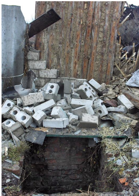
Фото б. Вид водопроводного колодца, расположенного с юго-восточного угла павильона
