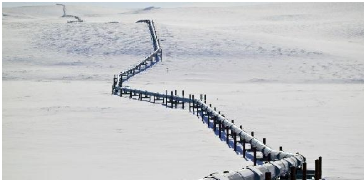
Рис. 2. Трубопровод в АЗРФ
