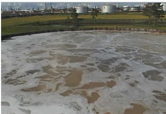
Рис. 4. Растекание воздушно-механической пены по «зеркалу» резервуара
