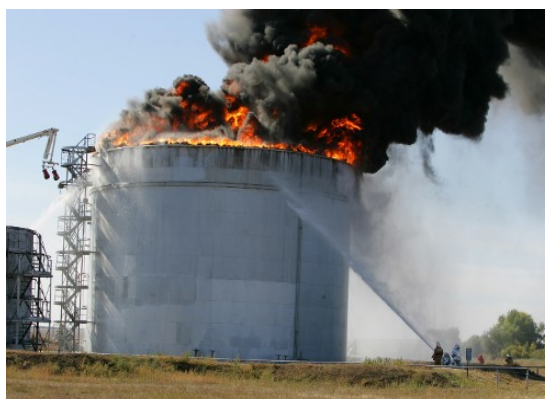
Рис. 1. Тушение пожаров в резервуарах с помощью передвижной пожарной техники
