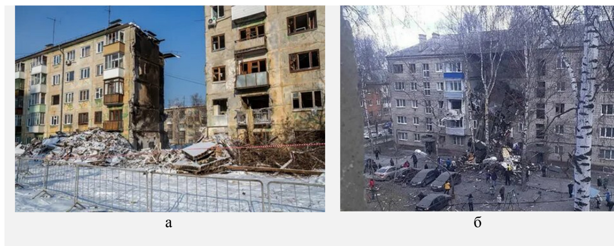
Рис. 1. Последствия взрывов газа в квартирах: а) г. Новосибирск; б) г. Орехово-Зуево
