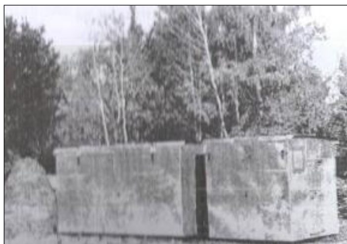
Рис. 3. Защитно-спасательное сооружение «Лес-6»
