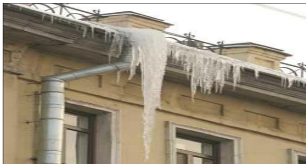
Рис. 3. Обледенение свесов и водосточных труб
