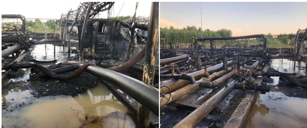
Рис. 1. Последствия аварии от 12 августа 2020 г. на дожимной насосной станции
