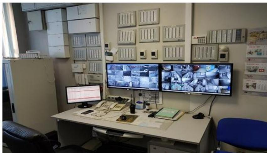
**Рис. 5. Модуль управления мониторингом и контроля пожарной безопасности объекта объединенного учреждения ФСИН**
