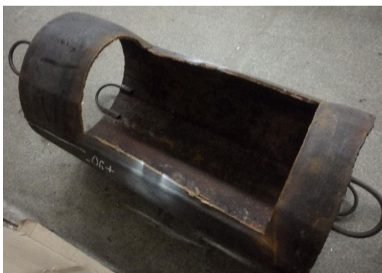
Рис. 9. Разрушение (резка) стальной трубы под водой
