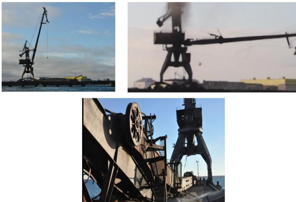
Рис. 5. Обрушение стрелы крана с применением ЗУВР
