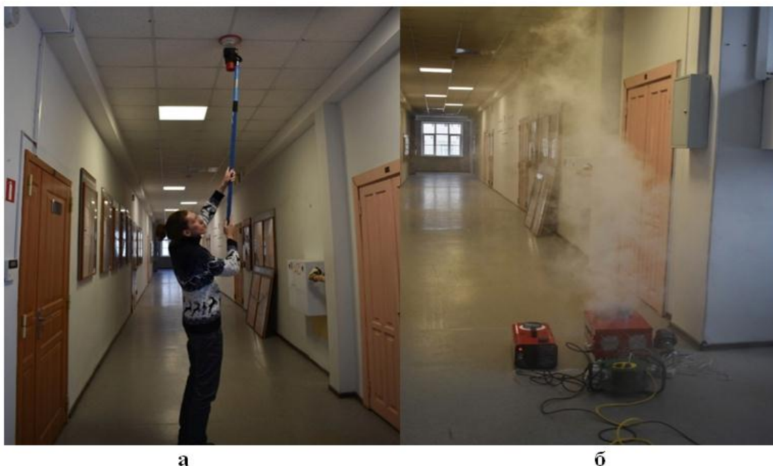
Рис. 7. Проверка пожарного извещателя при подготовке испытаний: а) тестовым аэрозолем; б) дымогенератором «Кипарис»
