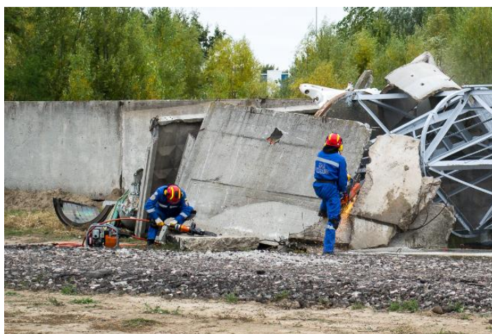
Рис. 8. Тренировка разбора завала здания (сооружения) с дальнейшим извлечением пострадавших ( https://ercom.aero/ )
