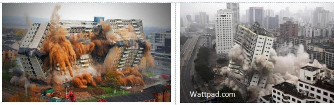
Рис. 4. Снос зданий (сооружений) взрывным способом
