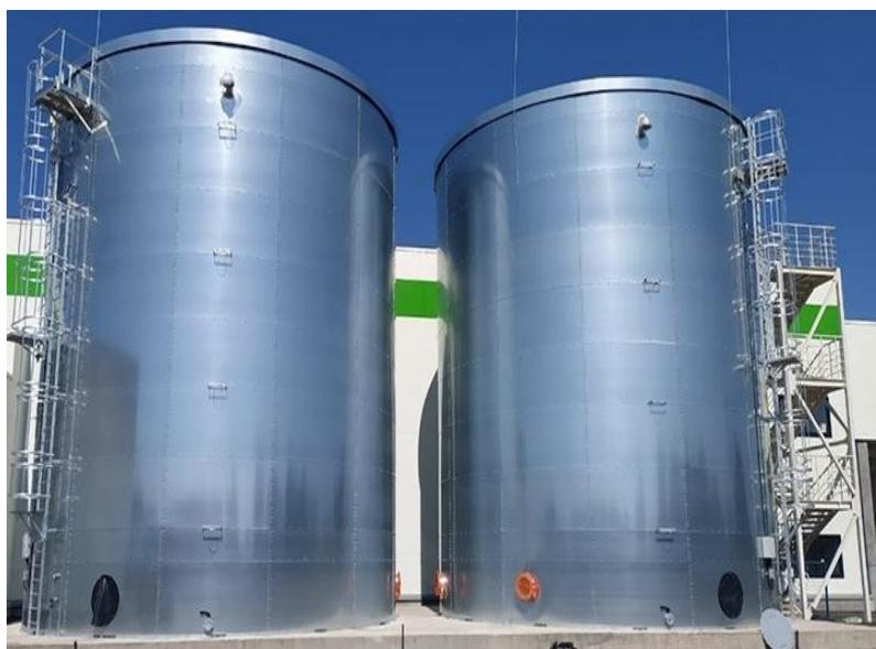
Рис. 1. РВС объемом более 1 500 м<sup>3</sup> для торгового комплекса в г. Пскове
