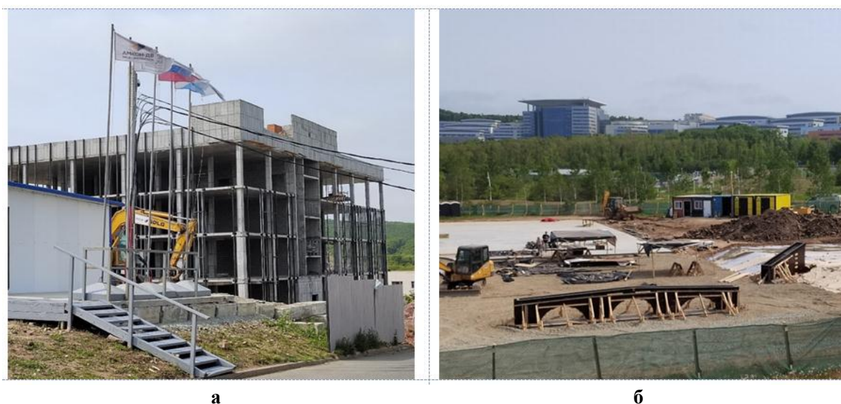
Рис. 1. а) Строительная площадка на Малом Аяксе; б) Строительная площадка у корпуса 5
