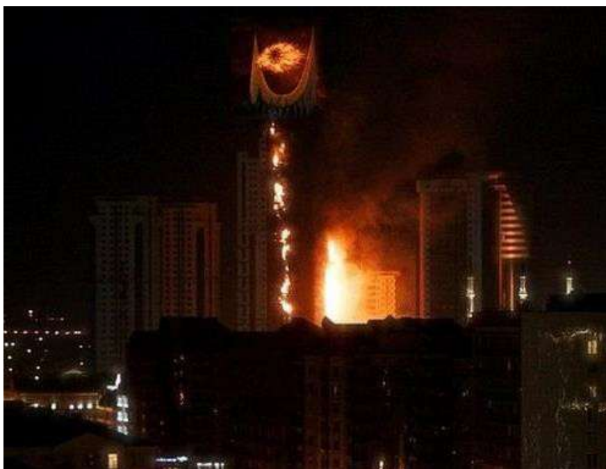
Рис. 4. Распространение пожара по всей высоте фасада здания без карнизов
