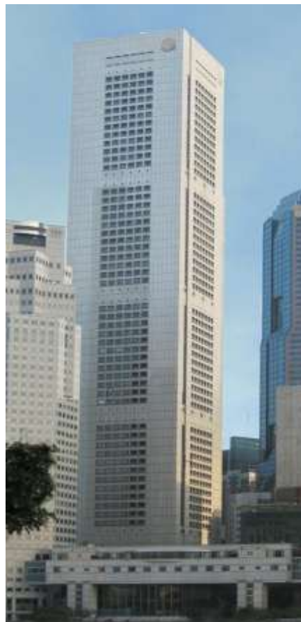
Рис. 2. Разделение здания по вертикали на пожарные отсеки с помощью технического этажа или пояса из негорючих материалов определенной высоты фасада с пределом огнестойкости примыкающего противопожарного перекрытия
