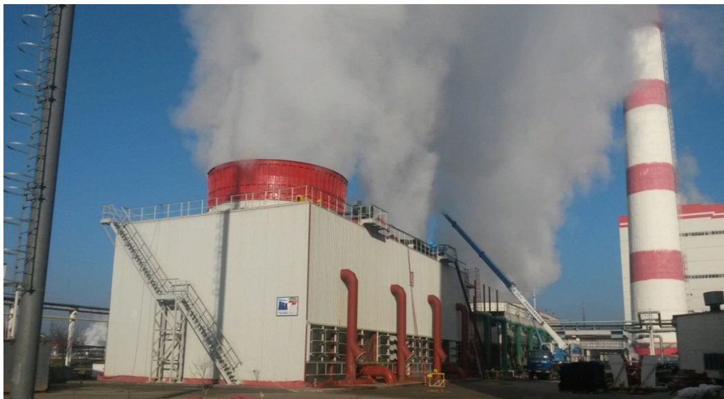
Рис. 4. Капельный унос воды из градирни
