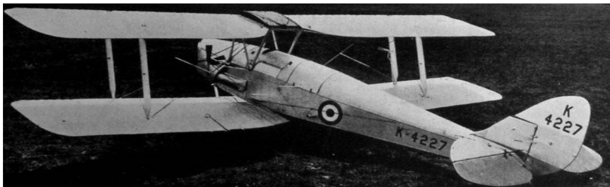
Рис. 2. Первый БПЛА, управляемый дистанционно Н.82В QueenBee (1933–1943 гг.)
