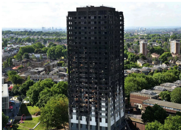
Рис. Последствия пожара в здании Grenfell Tower
