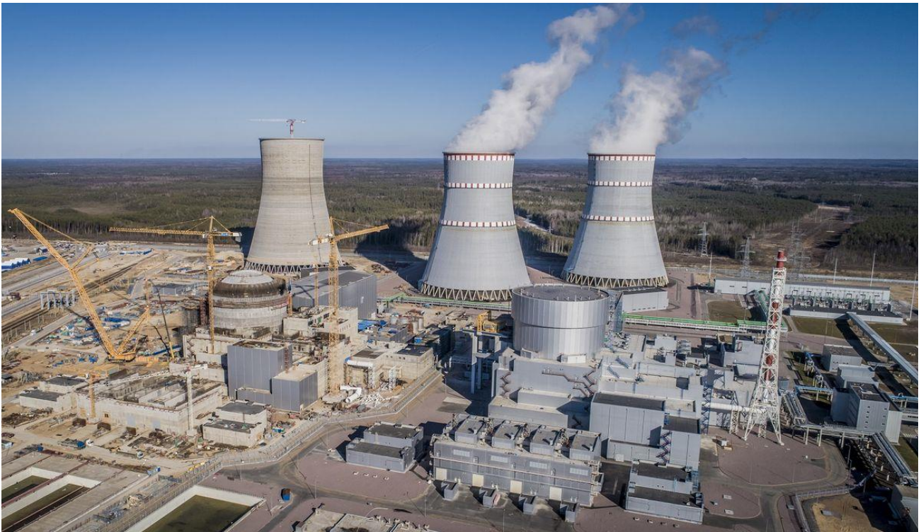
Рис. 1. Ленинградская атомная электростанция
