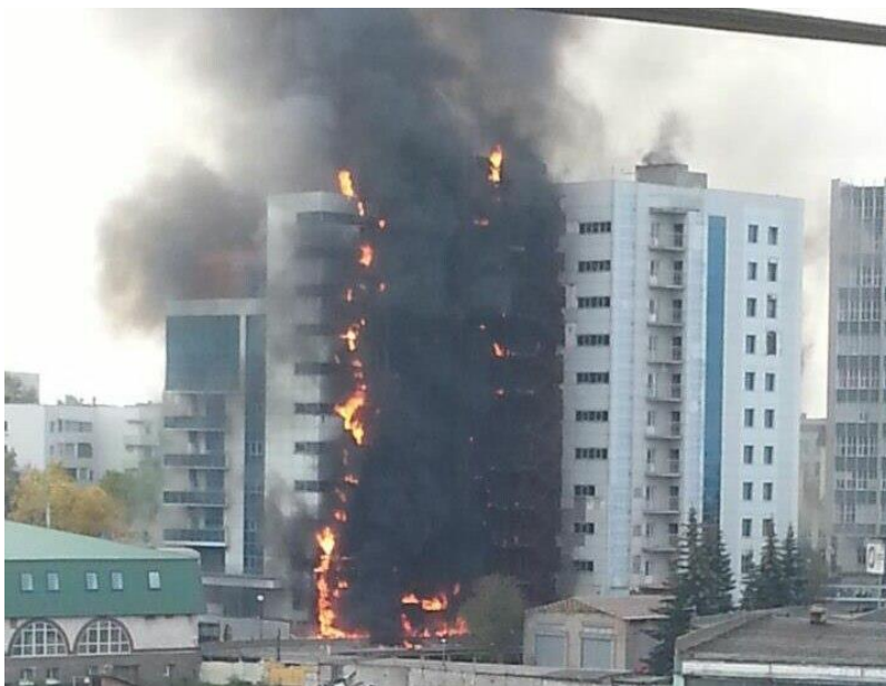
Рис. 2. Пожар здания бизнес-центра Башкирской генерирующей компании
