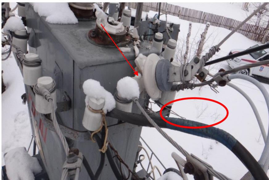
**Рис. 2. Обрыв изолятора высоковольтной линии (красная стрелка) и его замыкание на низковольтную линию (овал)**
