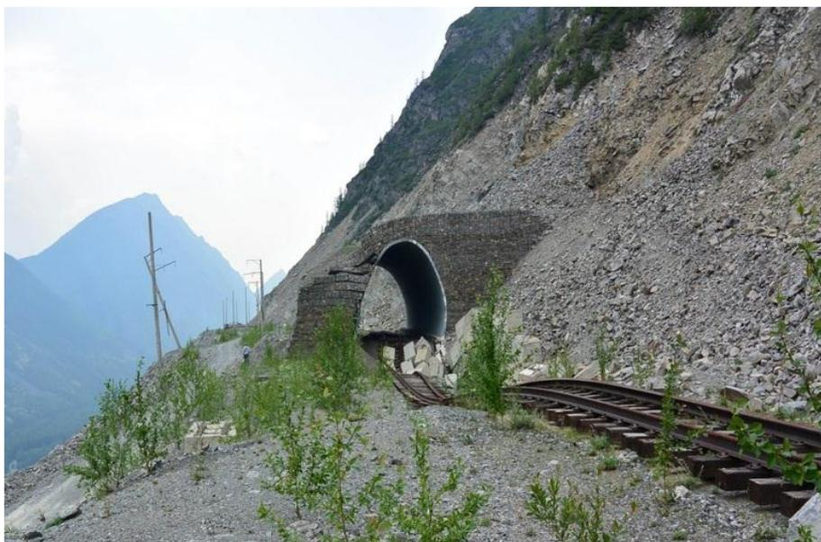
**Рис. 2. Разрушение железнодорожного пути, июль 2015 г.**
