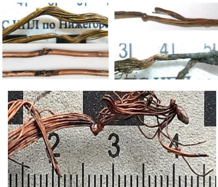
Рис. 3. Последствия неполного разрушения медных проводников при электродуговом процессе КЗ
