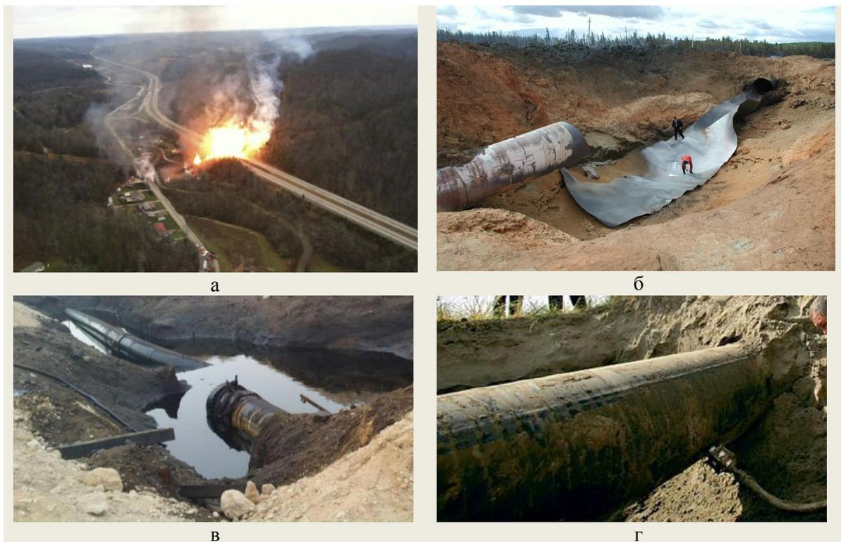
Рис. 2. Инциденты на нефтегазопроводах: а) пожар; б) взрыв газопровода; в) утечка нефтепродукта; г) врезка (фото из открытых источников в интернете)
