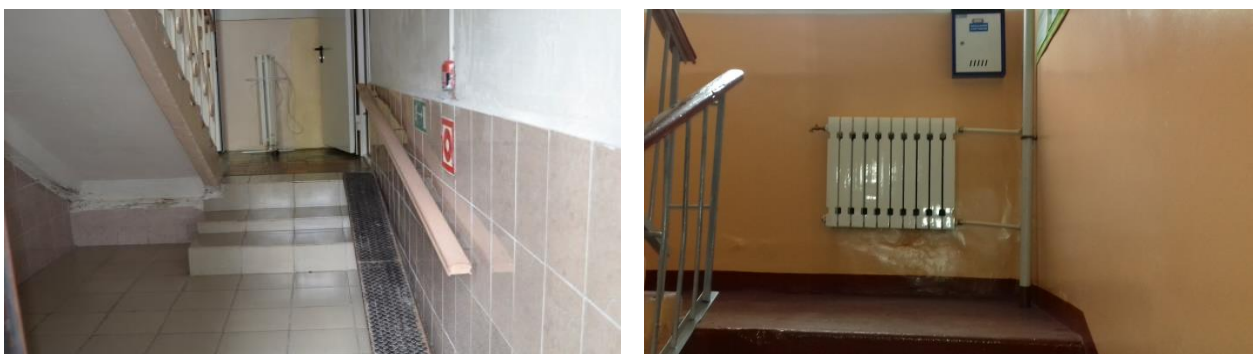
Рис. 2. Ступени различной высоты в лестничной клетке, выступ радиатора отопления
