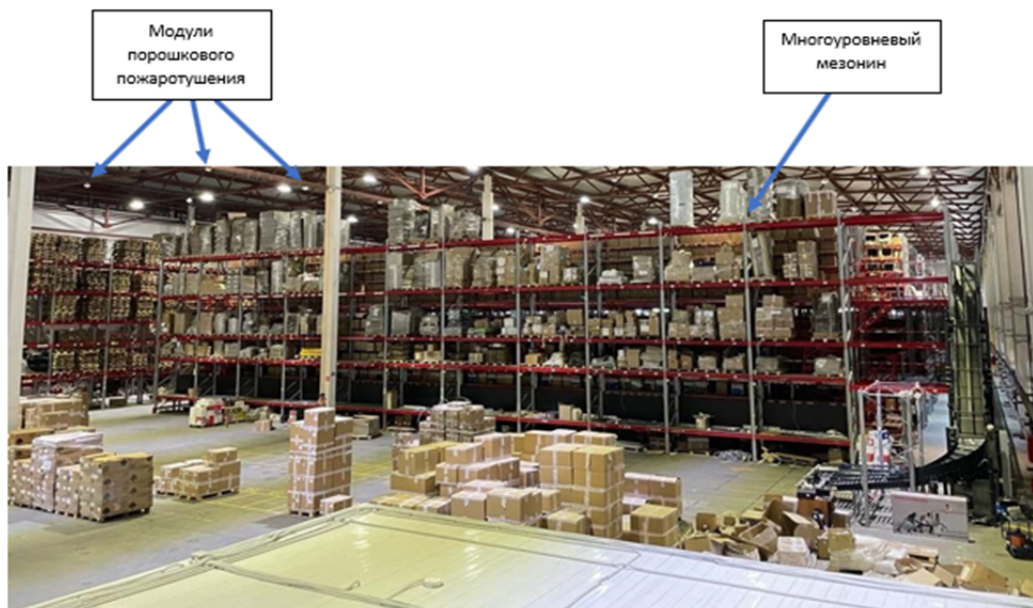
Рис. 2. Складское помещение с многоуровневым мезонином
