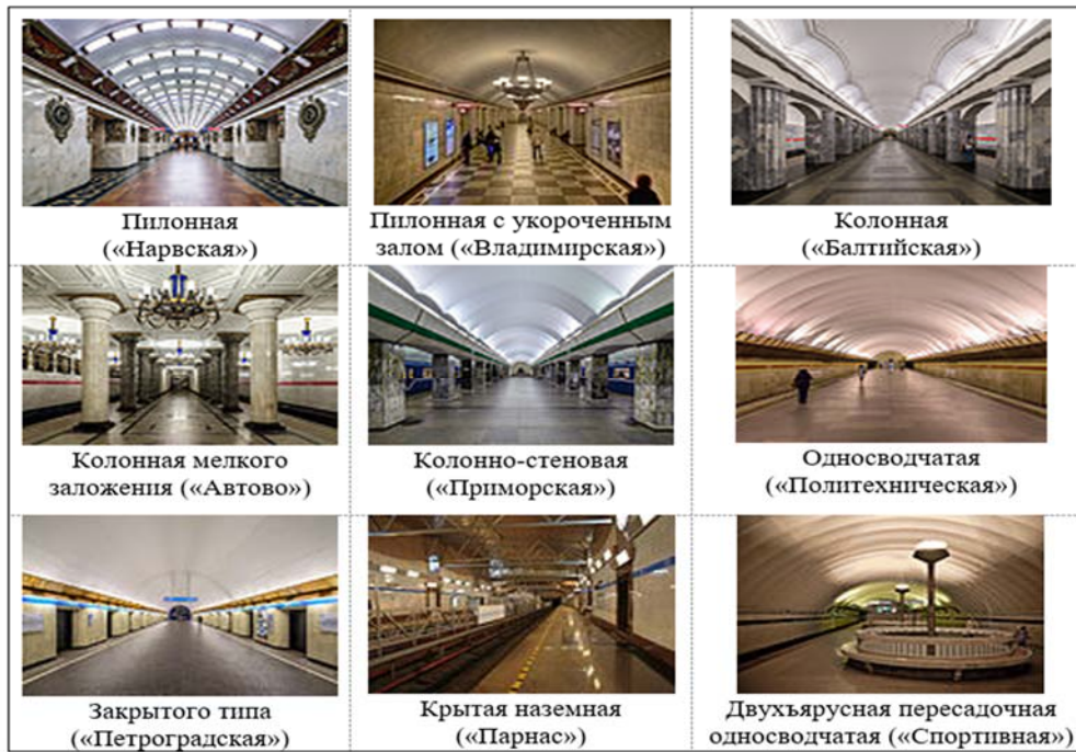
Рис. 3. Примеры видов станций Ленинградского/Петербуржского метрополитена (фото и схемы станций из открытого источника)
