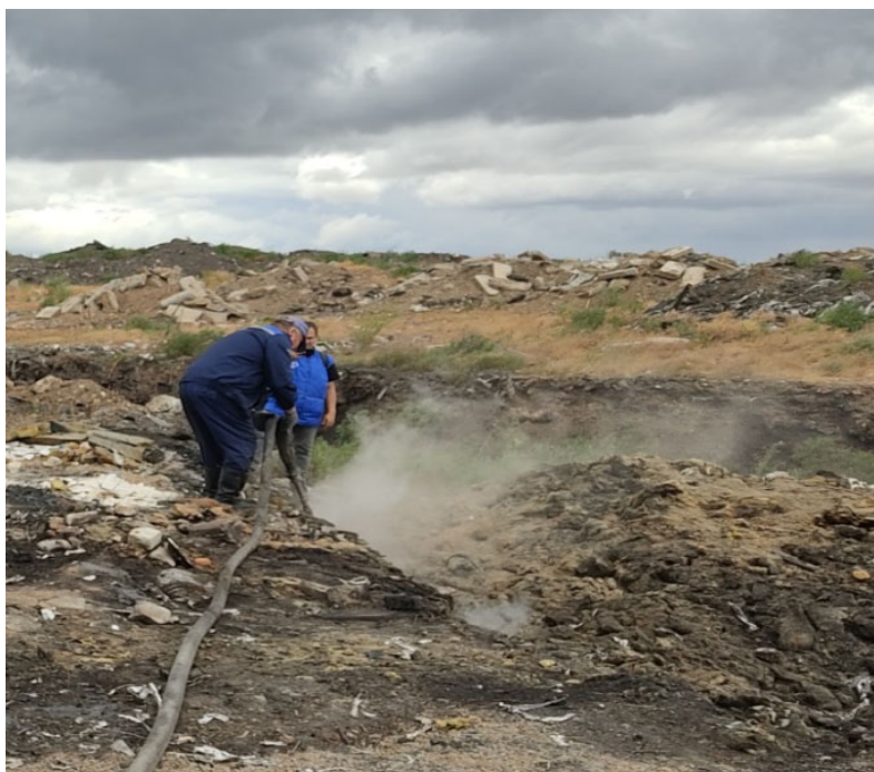
Рис. 2. Введение тушащей фосфорсодержащей суспензии в очаг возгорания
