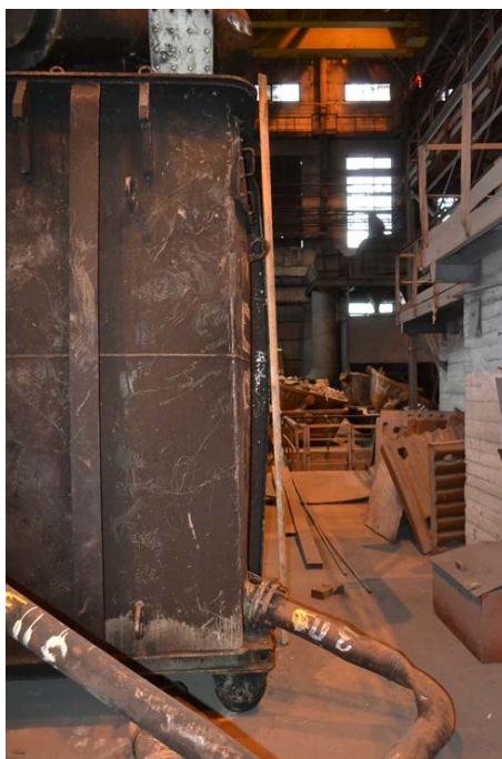
Рис. 6. Третий трансформатор печи № 3 – деформация задней стенки («бочковое» раздутие)
