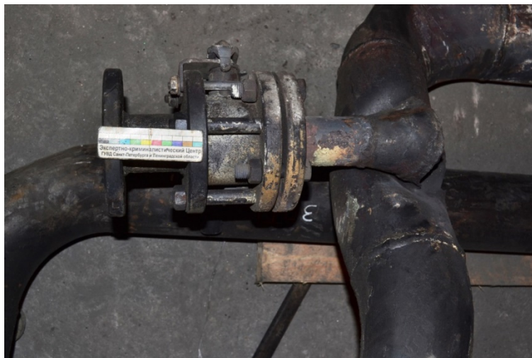
Рис. 8. Кран для слива масла, частично отделенный от трубы (по сварному шву)
