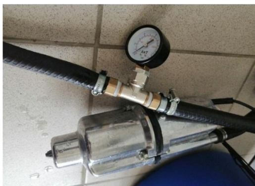
Рис. 2. Контроль подачи раствора пенообразователя прибором измерения давления
