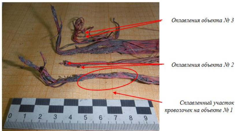
Рис. 3. Оплавления на объектах № 1–3 (отражено стрелками)
