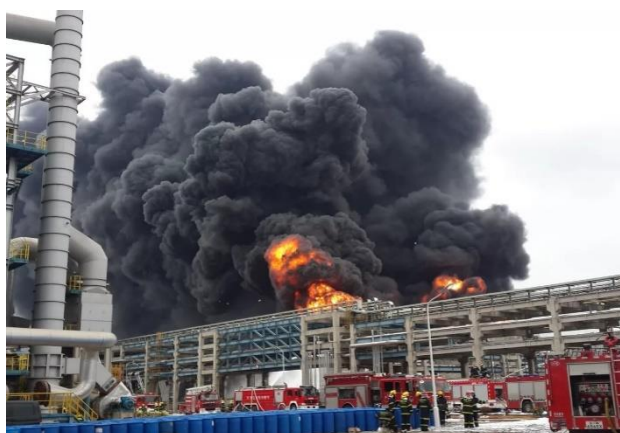
Рис. 1. Пожар на Комсомольском нефтеперерабатывающем заводе
